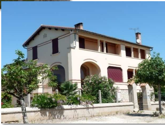
Maison des années 30 à la sortie Nord du village
