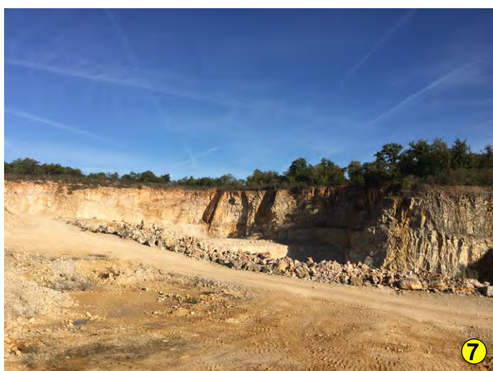
Secteur en cours d'extraction
