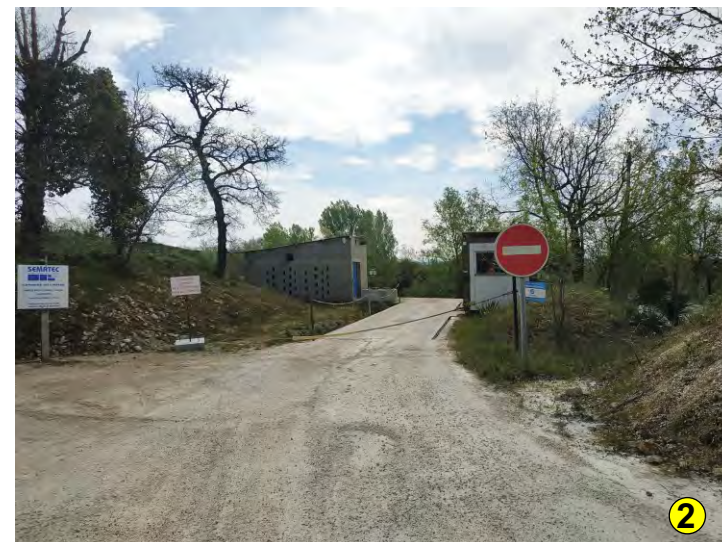
Sortie du site - bascule et local
