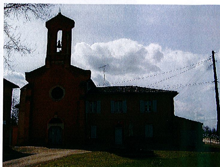
L'Eglise de Saint Pierre de Campredon
