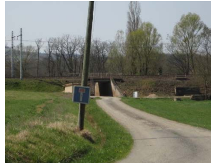
Pont sous la voie ferrée
