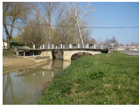
Pont de la RD 103 sur le Candé
