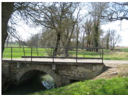
Lieu-dit Sainte-Eulalie Pont sur le Candé
