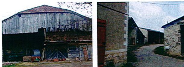
Bâti agricole traditionnel, avec bardage bois, toiture avec demi-croupe, arrêtes du bâti soulignées, implantation en accroche à la voie, etc.
