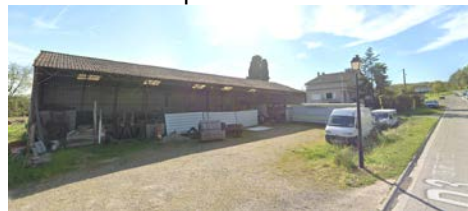
Hangar attenant à une habitation
