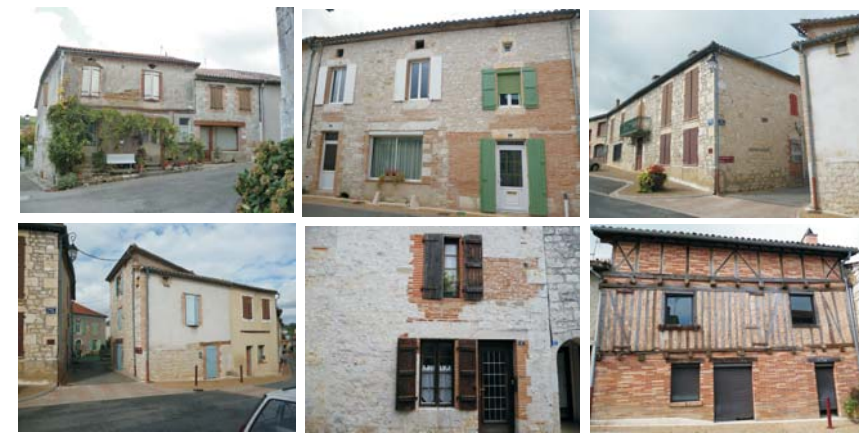
Unique façade à colombages remplie de briques cuites
