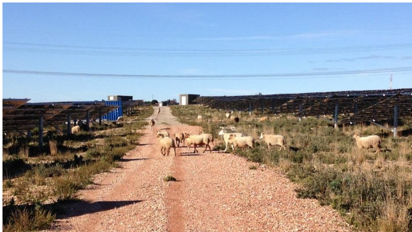
Figure 18 - CENTRALE SOLAIRE DE ROCHEFORT-DU-GARD (30)
