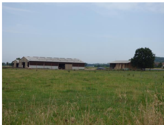
Bâtiments d'élevage à l'Est sur la terrasse
