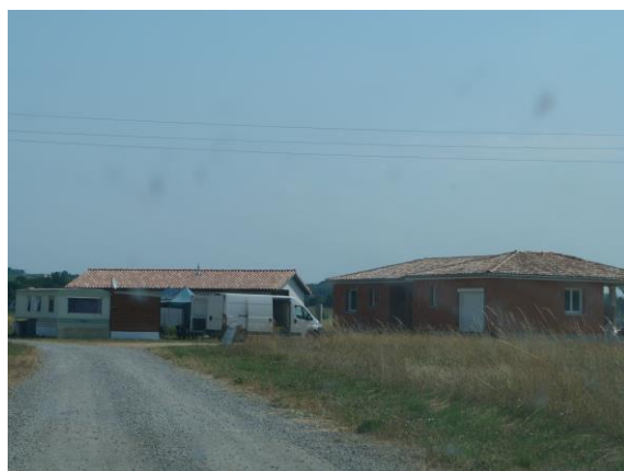
Constructions en cours au centre de la zone
