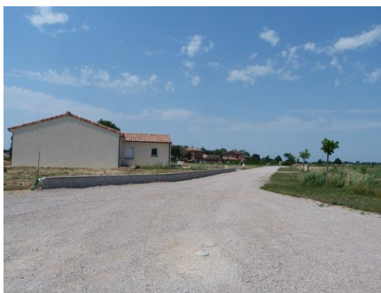
Construction en cours sur le nouveau lotissement
