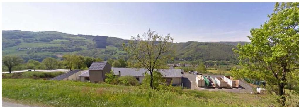
Bâtiments artisanaux existants
