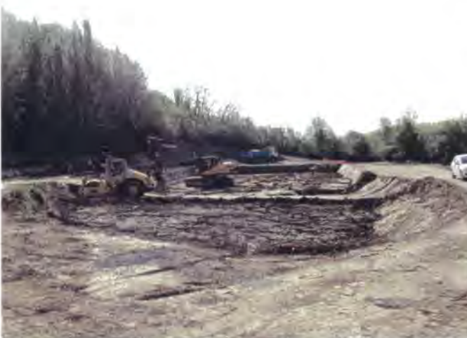
Terrassement en cours dans un bassin de lagunage.
