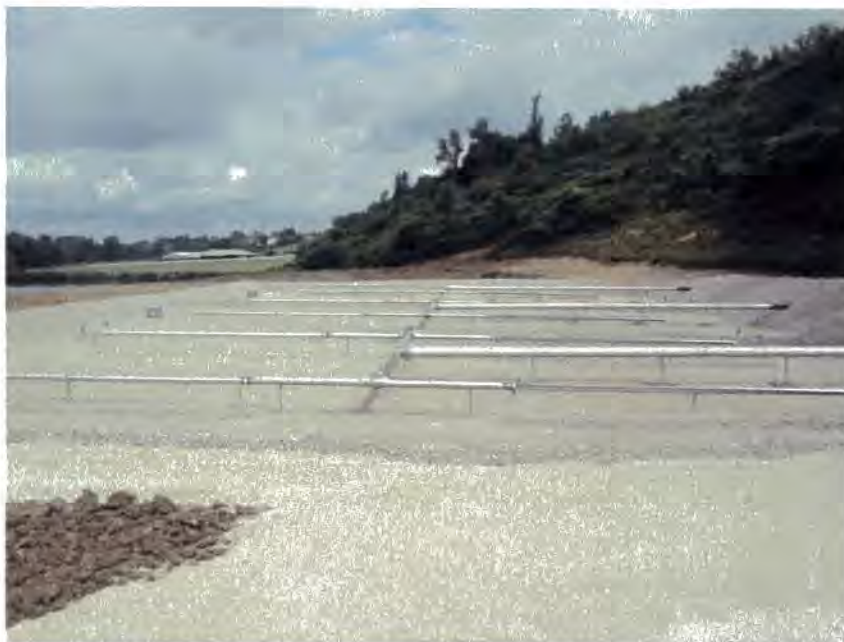
Filtre planté de roseau (1000 eqH) implanté dans un 1er bassin de lagunage : commune de Villebrumier
