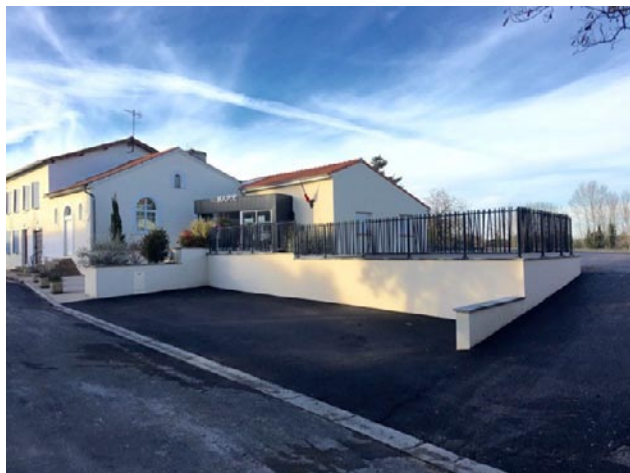
Mise aux normes accessibilité de la Mairie (Réalisé)
