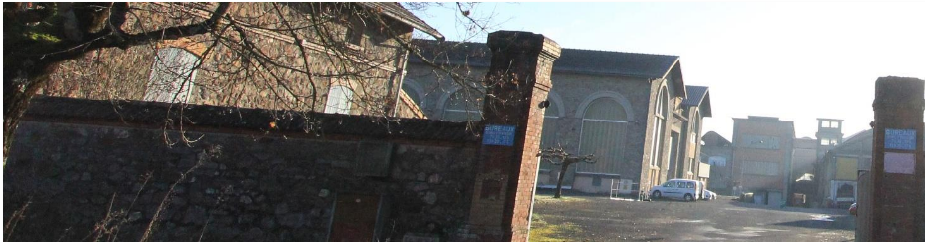
Vue sur une ancienne usine au Nord de Saint-Benoit-de-Carmaux, utilisé de nos jours par l'ASEI, structure sociale pour l'accompagnement, l'éducation et l'insertion des personnes handicapées
