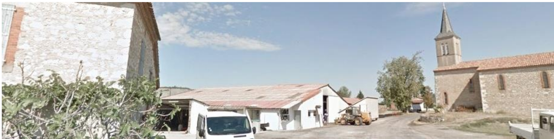
Vue intérieure du hameau de-Sainte-Martianne au Garric. Ces formations s'organisent autour de placettes, d'espaces publics communautaires qui ne se retrouvent pas dans l'urbanisme linéaire.
