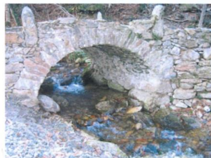
Fig. 4 - Vue de l'arche du pont de pierre.
