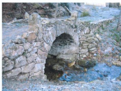
Fig. 5 - Vue de l'arche du pont de pierre.
