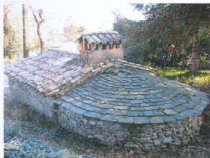
Fig. 1 - Vue de la couverture du four.
