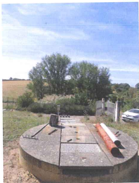
La station d'épuration
