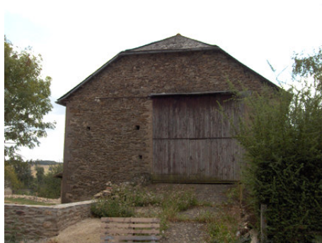
Construction en pierres apparentes et couverture en ardoises au niveau du bourg
