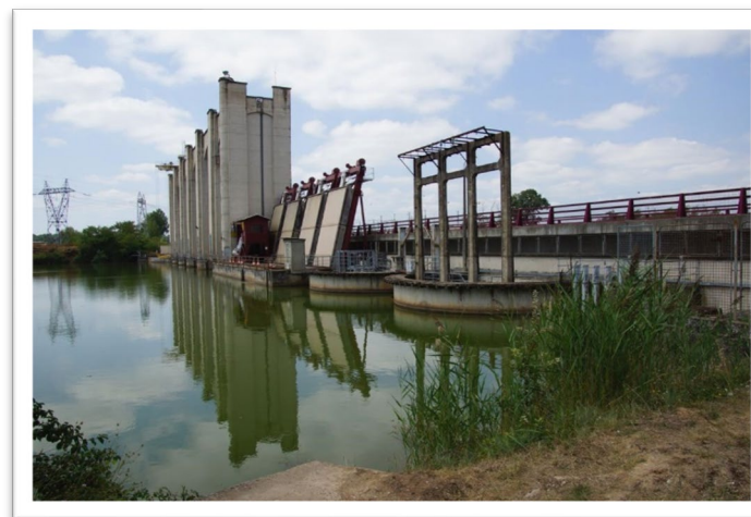
Barrage hydroélectrique de Rivière sur le Tarn
