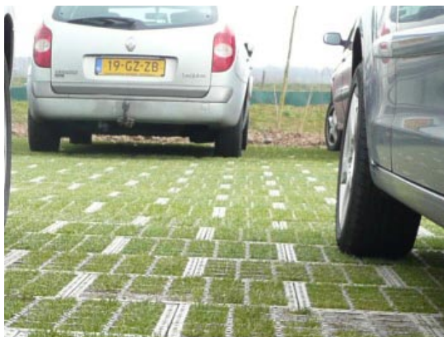
Les dalles engazonnées donnent l'assurance d'un revêtement stable, propre à supporter le poids des véhicules, sans altérer la perméabilité du sol.
