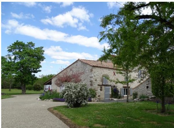
Bâti rénové - La Garrigue
