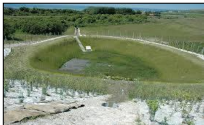
Bassin de rétention
