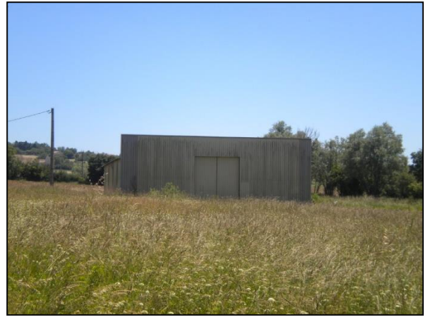
Ancien bâtiment d'activité
