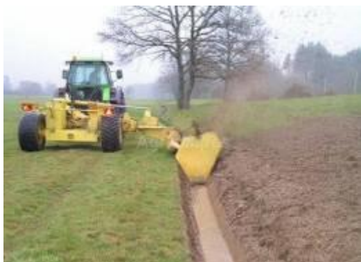
Figure 17 : Exemples de curage et reprofilage de fossé
