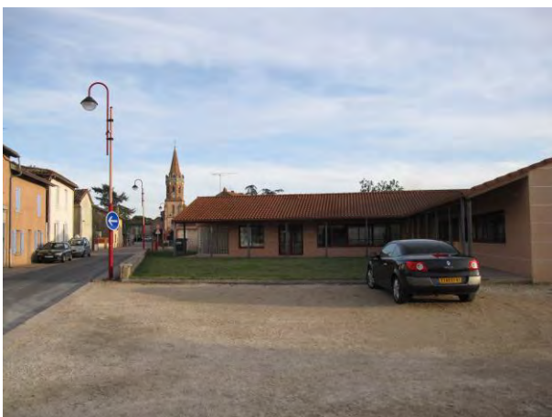
Parc de stationnement du groupe scolaire
