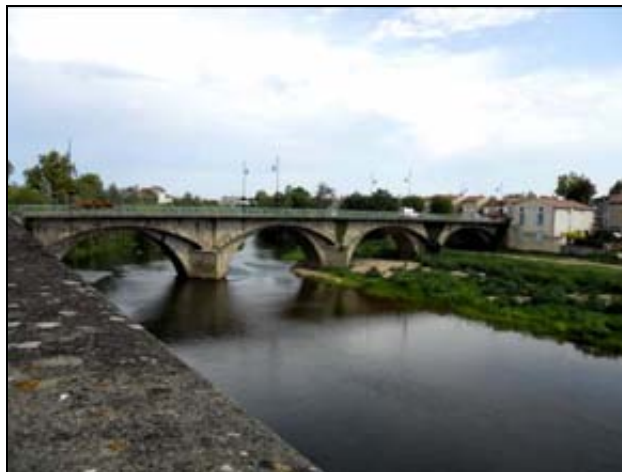
Pont Guillemet - Traversée du Thoré en sortie de centre-bourg
