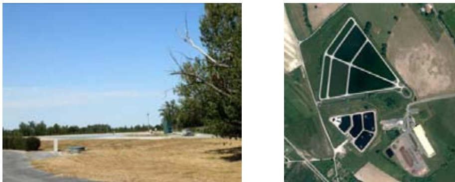
Vues sur la station d'épuration
