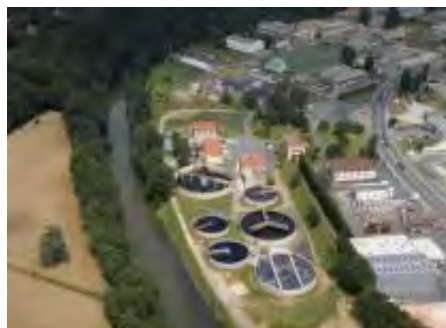
Figure 108 : Station d'épuration mixte de Graulhet, source : fonds communal.
