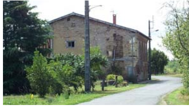
Le hameau de Lagassié, espace bâti composé, à valoriser
