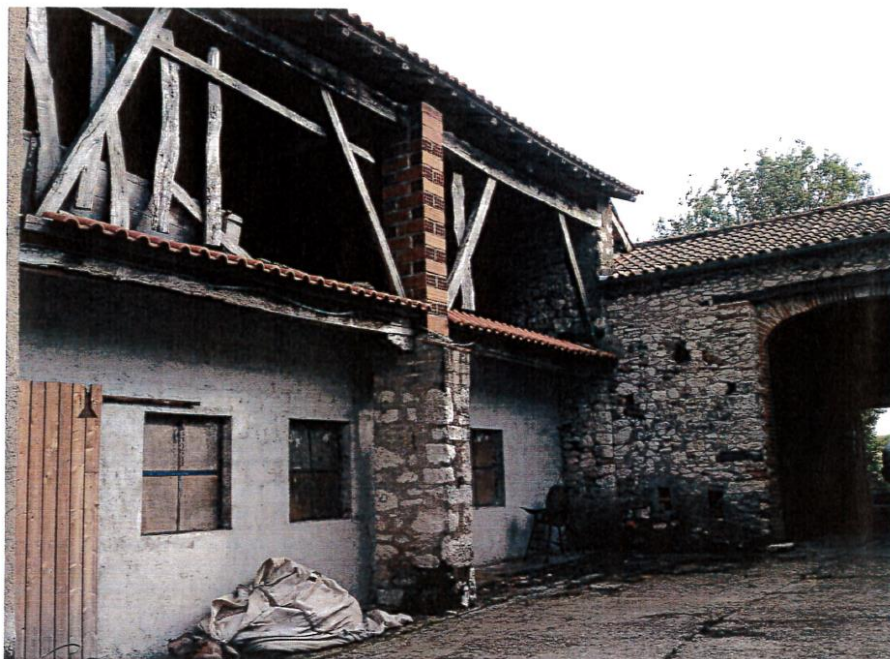
PHOTO N° 6 : Bâtiment ancien Parcelle N° ZI 0034 Lieu-dit Le Truel
