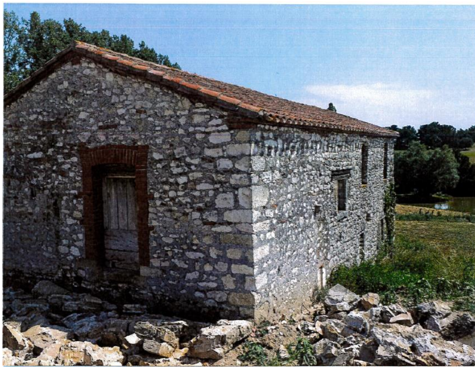
Photo n°8 : Bâtiment ancien Parcelle n° ZD 83 Lieu-dit Ferratiès Basses
