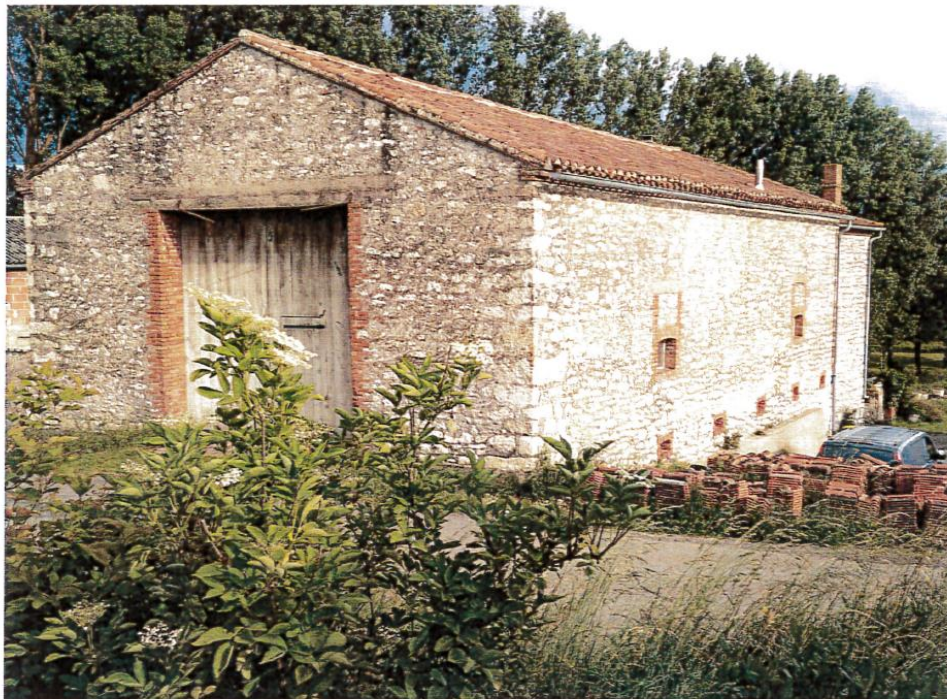
PHOTO N° 3 : Bâtiment ancien Parcelle N° ZD 0083 Lieu-dit Ferratiés Basses
