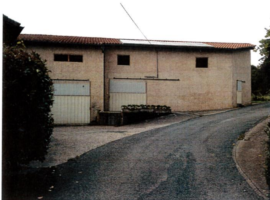
PHOTO N° 1 : Bâtiment ancien Parcelle ZO 54 Lieu dit Barret
