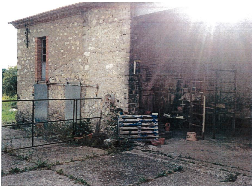
PHOTO N° 4 : Bâtiment ancien Parcelle N° ZD 0082 Lieu- dit Ferratiès Hautes
