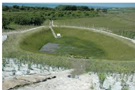
Bassin de rétention
