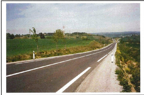
Désenclavement et désengorgement de la ville de Castres par la réalisation de rocades et de voies urbaines
