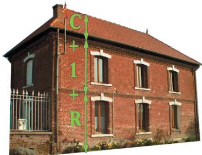
Hauteur d'une maison du village
