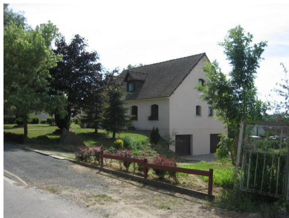
Implantation du bâti sur terrassement en déblais avec le sous-sol comme fondation de l'édifice (1980-1990)
