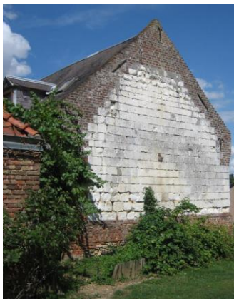
Pignon en pierre sur soubassement de brique et de grès, surélevé en brique
