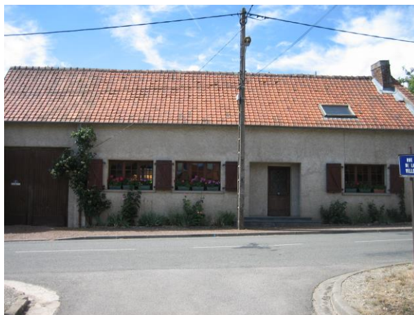
Couverture en tuiles mécaniques orange
