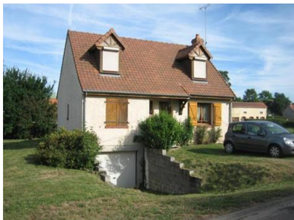
Implantation du bâti sur terrassement en déblais avec le sous-sol comme fondation de l'édifice (1980-1990)
