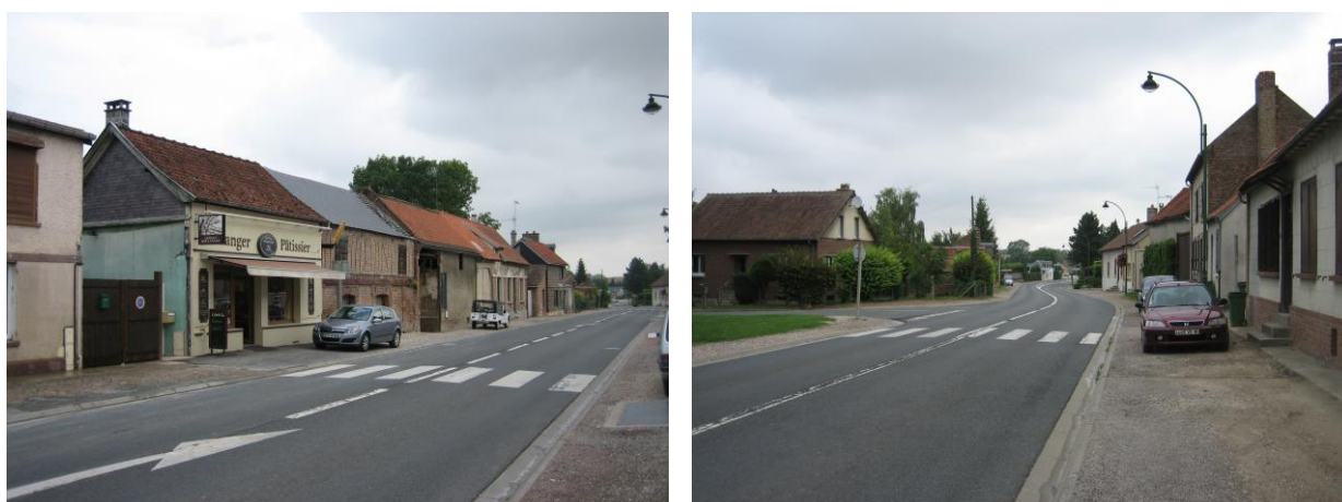
Des largeurs de trottoirs importants
