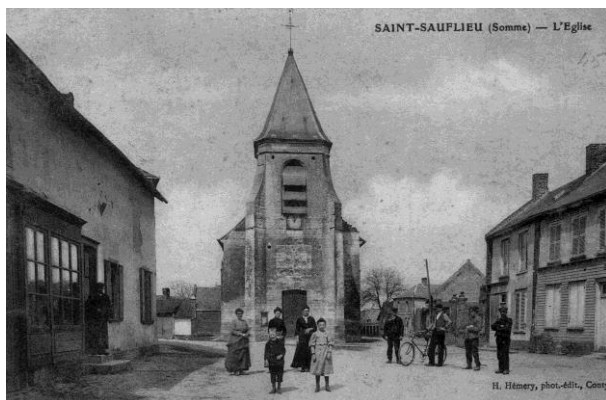
Place rue de la Ville (1907)
