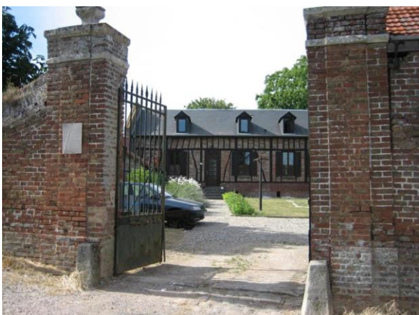
Réhabilitation en brique d'un logis colombage bois
