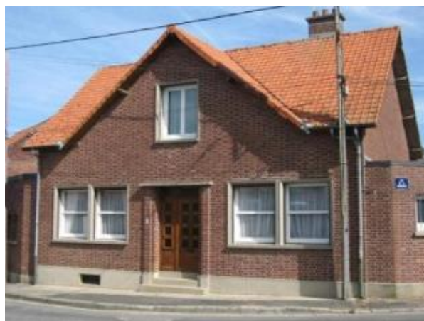
Maison en briques / Tuiles plates / Fenêtres verticales (1950)
