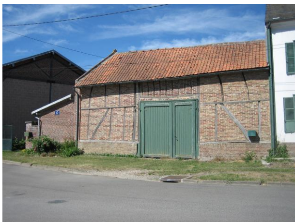
Ossature bois et remplissage en terre cuite
