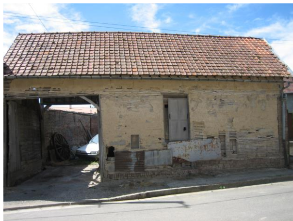
Torchis, bois et briques en soubassement
