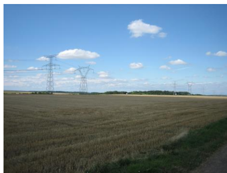
Lignes Haute Tension
