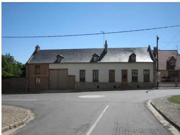
Couverture en ardoises
