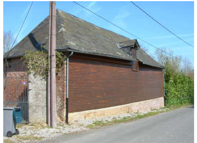
Annexe à l'alignement de la voie, rue Montchaux
