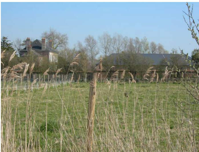
En fond de vallée humide, au lieu-dit les Amourettes, le bâti traditionnel est en partie voué à l'accueil touristique, par le biais de gîtes ; quelques structures se répartissent ainsi dans la commune
