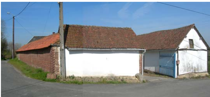
Ancienne fermette en partie avale de la rue Seigneur
