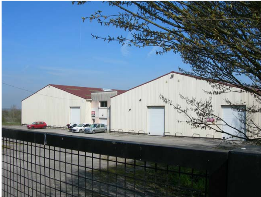
Bâtiment d'activités, CR dit de la Valléette
