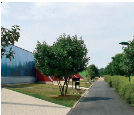
Parc d'activités du lac de la Monnerie à La Flèche (72) - Feuille à feuille, paysagistes Exemple de voirie et desserte
