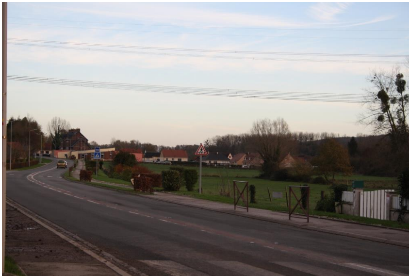
Photo : Route Départementale n°1015
