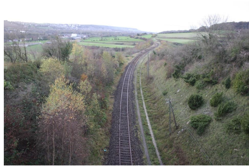
Photo : Voie de chemin de fer traversant la commune
