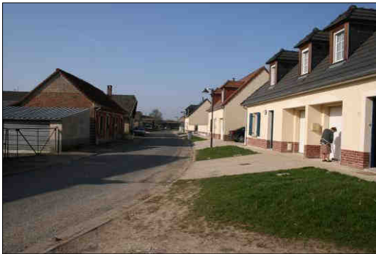
Logements locatifs de la rue du Bois
