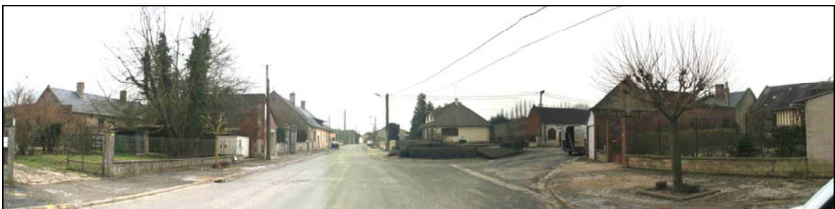
Raccordement de la RD154 et de la VC1 dans le village
