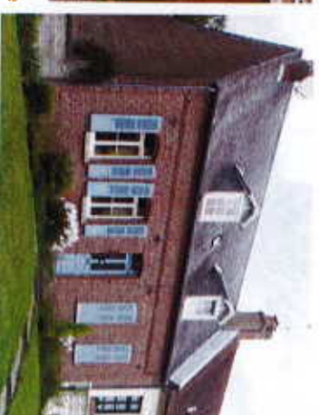
Maçonnerie de brique appareillée polychrome
