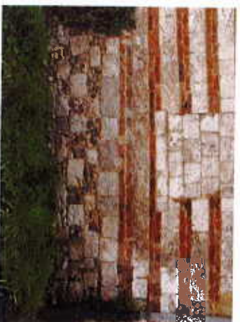
Maçonnerie mixte de pierre calcaire et de brique appareillée en bandes picardes. Le soubassement est traité par une maçonnerie de calcaire et silex appareillée en damier.
