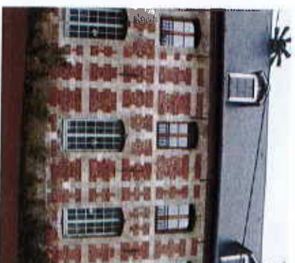
Maçonneries mixtes de pierres calcaires et briques. Appareillage en bandes picardes et pignon à "couteaux"
