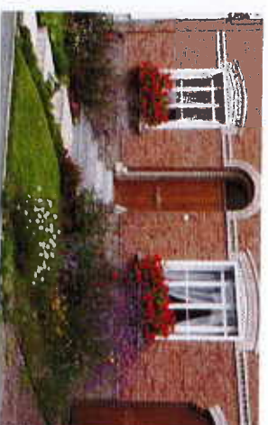
Maçonnerie de brique appareillée polychrome
