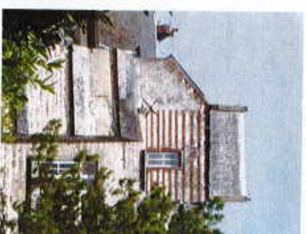
Maçonneries mixtes de pierres calcaires et briques. Appareillage en bandes picardes et pignon à "couteaux"
