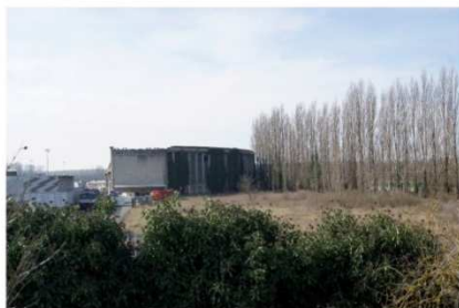
LA ROTONDE PATRIMOINE ARCHITECTURAL
