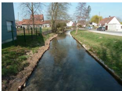
Exemple de stabilisation de berges avec des techniques végétales sur la rivière l'Airaines en cœur de bourg, ou des parements ponctuels nécessités par les contraintes hydrauliques
