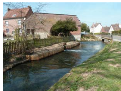
Exemple de stabilisation de berges avec des techniques végétales sur la rivière l'Airaines en cœur de bourg, ou des parements ponctuels nécessités par les contraintes hydrauliques
