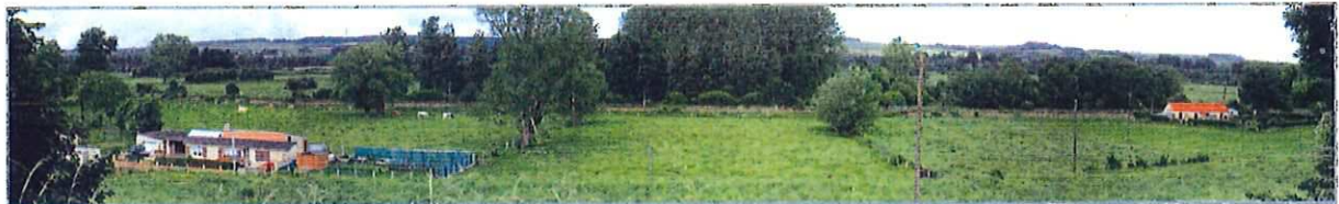
16- Les constructions isolées de la rue Solle
