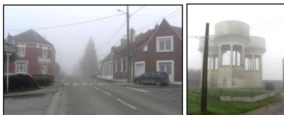
RD35, château d'eau à l'entrée de LICOURT
