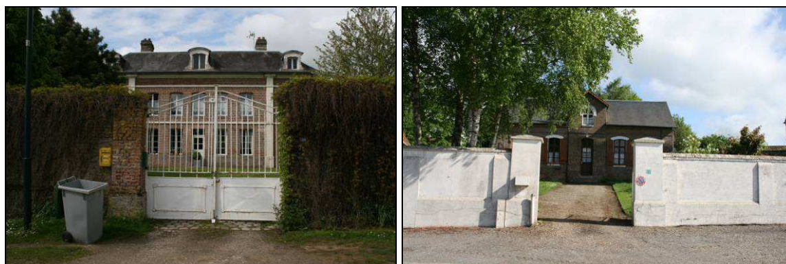
Habitation Grande rue à Ouville et l'ancien presbytère à Hautvillers
