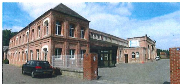
Bâti industriel pour les activités ERGOS et CESA, Rue de la République
