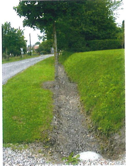
A Wanel, la topographie accidentée implique que l'espace public prenne aussi en compte la gestion des eaux pluviales
