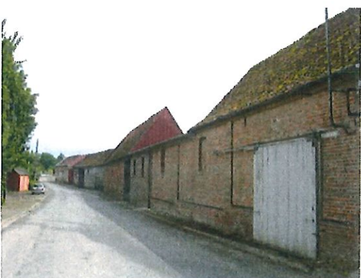
Alignement de granges, Rue des Marettes à Wanel
