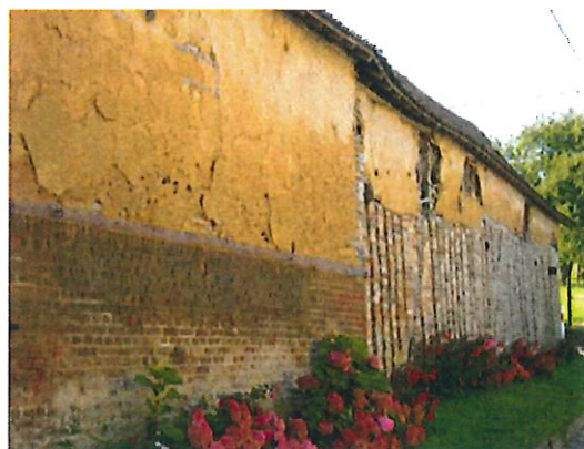
Dépendance de composante traditionnelle, en alignement, rue de Beauvoir à Hocquincourt
