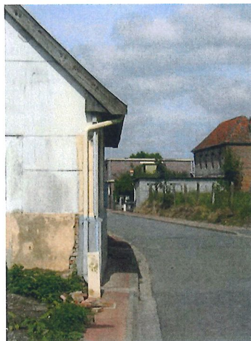
Il est important, au sein des cheminements, de traiter de l'espace piétonnier et de sa qualité (traitement, sécurité etc...) ; ici, Rue Douville Maillefeu, cet espace présente des portions très insuffisantes en terme de gabarit
