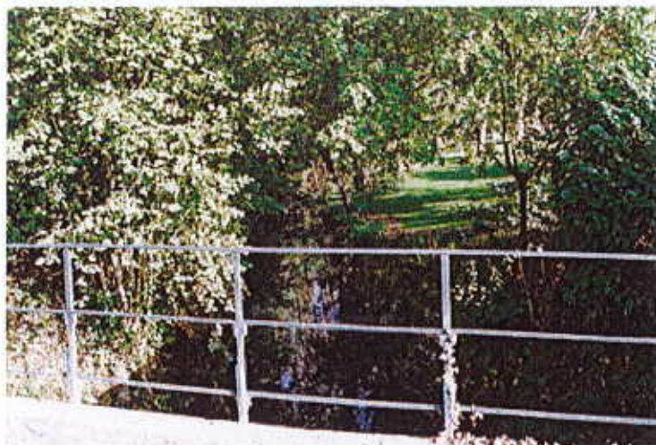
Un des ponts traversant la Grouche (Chemin de Malfourrière).
