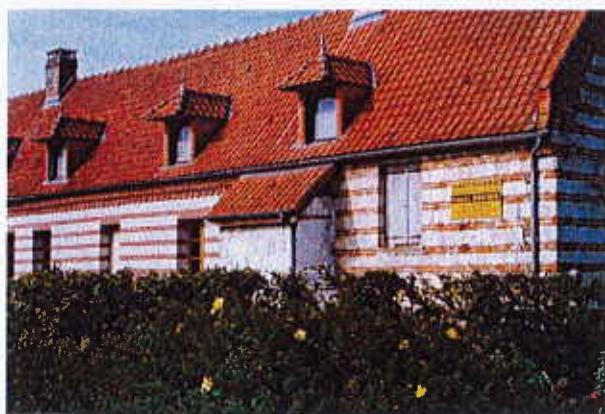
Rue des Ecoles, une rénovation à l'ancienne des murs
