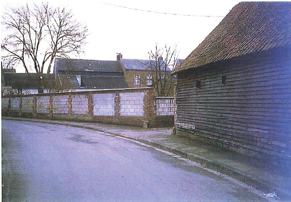
L'architecture traditionnelle : murs de craie et de brique
