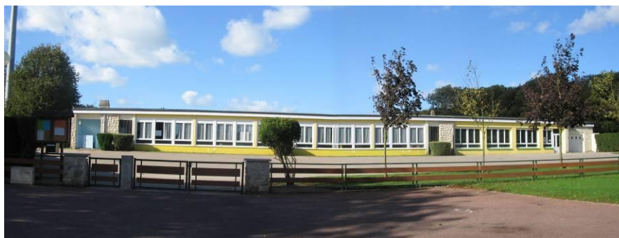
L'école, située derrière la mairie, Rue du Grand Patis
