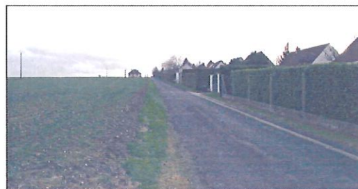
83- Chemin adossé au lotissement et desservant la zone 3 (CE n°4 et 5) vers le Sud.
