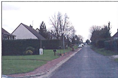
45- Le lotissement et la Rue du Soleil Levant
