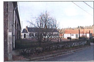
72- Ancienne ferme réhabilitée
