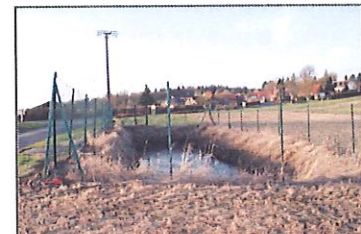
7- Bassin de rétention des eaux de ruissellement en amont du village
