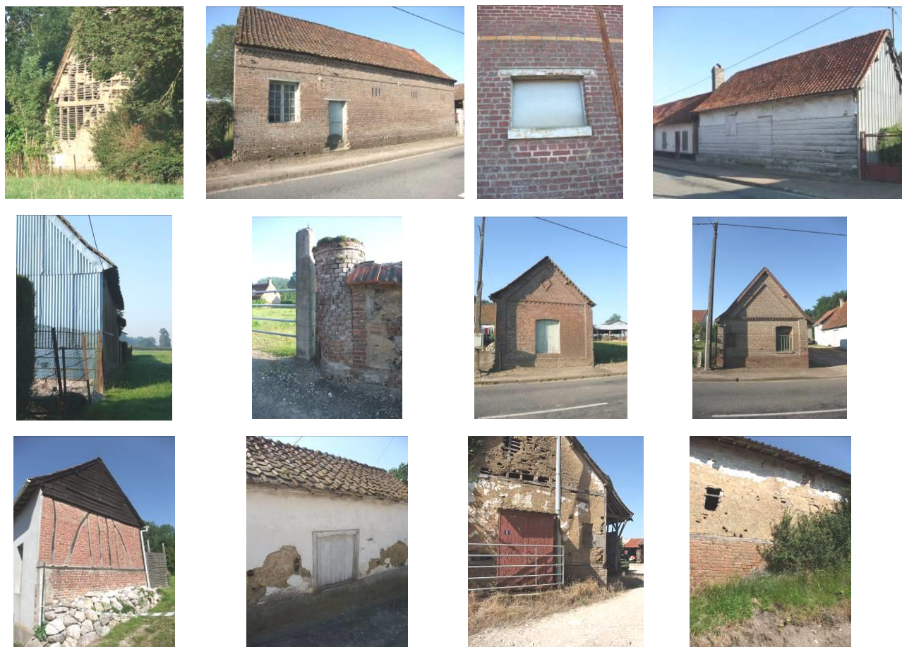
Photographies ci-dessus : détails de murs, appareillages, sous-bassement
