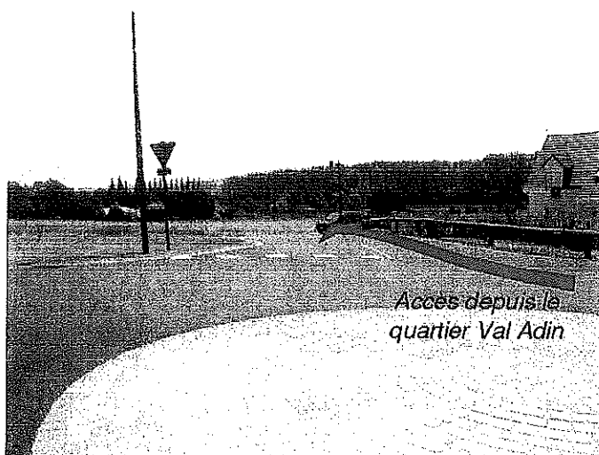
Accès depuis la voie en attente du quartier Val Adin
