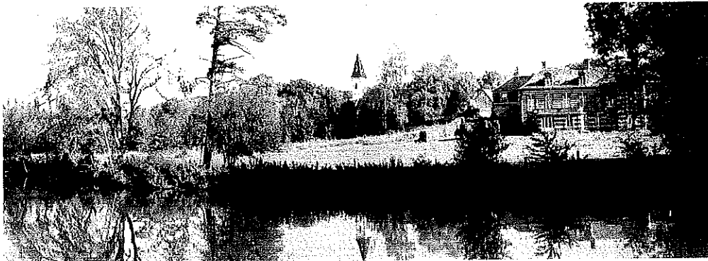
Vue de l'église et du château d'Epagne depuis le chemin de halage
