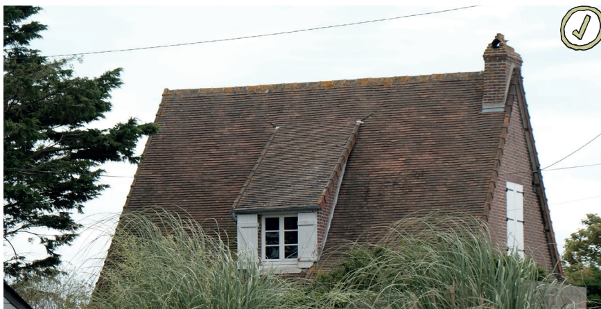
Lucarne rampante typique des maisons de la seconde reconstruction
