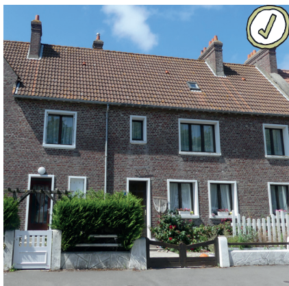
La fenêtre de toiture est de petite dimension et positionnée dans l'axe des baies de façade.
