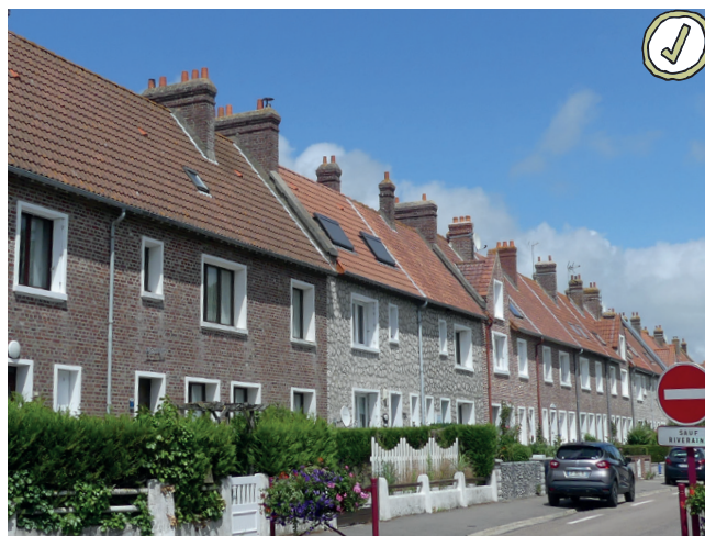
La façade du Quai Gavois est remarquable par la conservation des parements d'origine en brique et en opus incertum. La modularité des habitations, le rythme des façades et le jumelage a été préservé. On notera toutefois l'ajout de percements trop larges et très visibles en toiture
