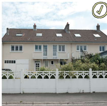
Les fenêtres de toitures sont positionnées dans l'axe des baies.
