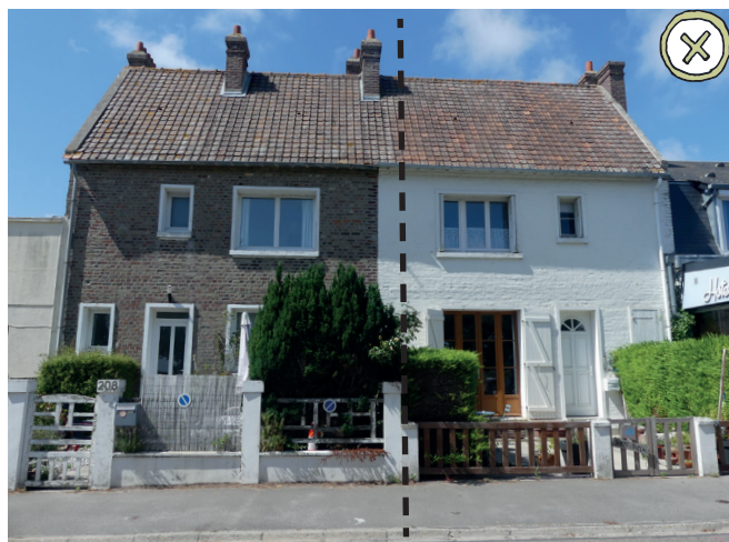
Les deux maisons font parties de la typologie «Maison mitoyenne jumelée». Les transformations sur la façade de la maison de droite (ajout de percements et l'application d'une peinture claire sur la brique) ont altéré la lisibilité de la modularité et du jumelage.
