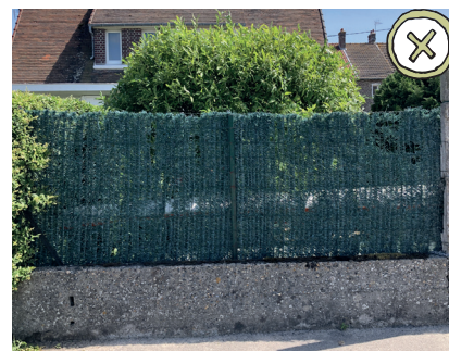
Des palissades ont été fixées sur les socles de l'ancienne clôture - Troisième Paysage.
