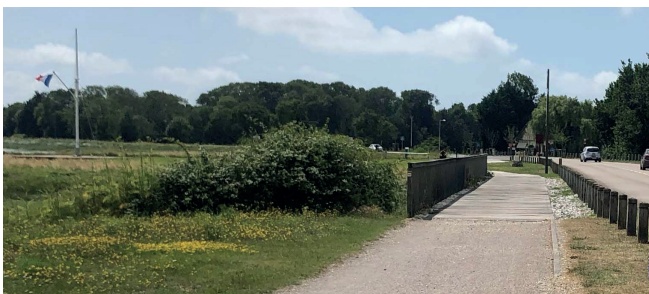
La voie douce partant du Hourdel : transition des matériaux, utilisation de bois, et ouverture des paysages vers la baie et le courant à poissons - Troisième Paysage
