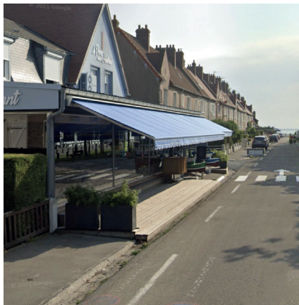
Circulation sur le trottoir bloquée par le platelage en bois surélevé - Google Streetview.
