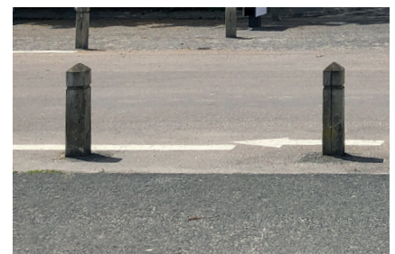
Exemple de poteaux bois à la pointe du Hourdel - Troisième Paysage.
