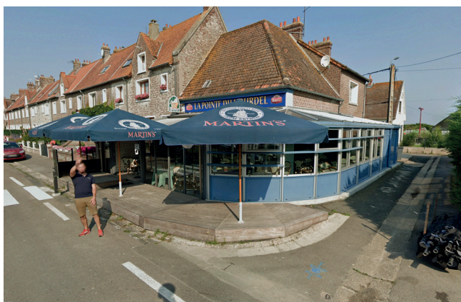
2024 : Restaurant la Pointe du Hourdel, le Hourdel, Photographie Google Earth. Les deux façades du café sont obstruées par l'ajout de la véranda. On ne distingue plus les fenêtres et les matériaux de l'édifice. La clôture basse en béton ajourée a été déposée. La terrasse du restaurant empiète sur le trottoir interrompu. Une enseigne en bandeau et une enseigne en drapeau couronnent la véranda.
