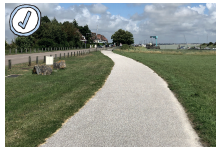
Revêtement unique, voie verte entrée du hameau - Troisième Paysage.
