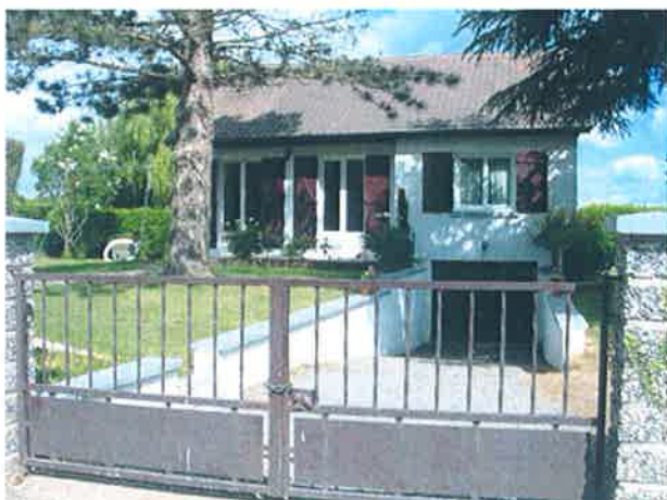
Habitat récent, rue de l'Hermitage
